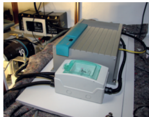
Door de regelenheid en acculader op de schotten van de motorruimte te monteren worden verliezen in lange kabels voorkomen.
