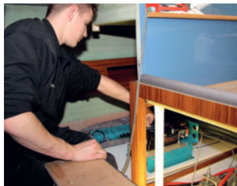
Montage van de regelenheid, het hart van de elektrische voortstuwing aan boord van de Essence 33.
